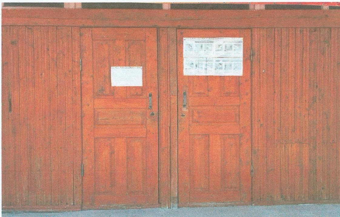
Фото 5 Дверь входная (наружная)
